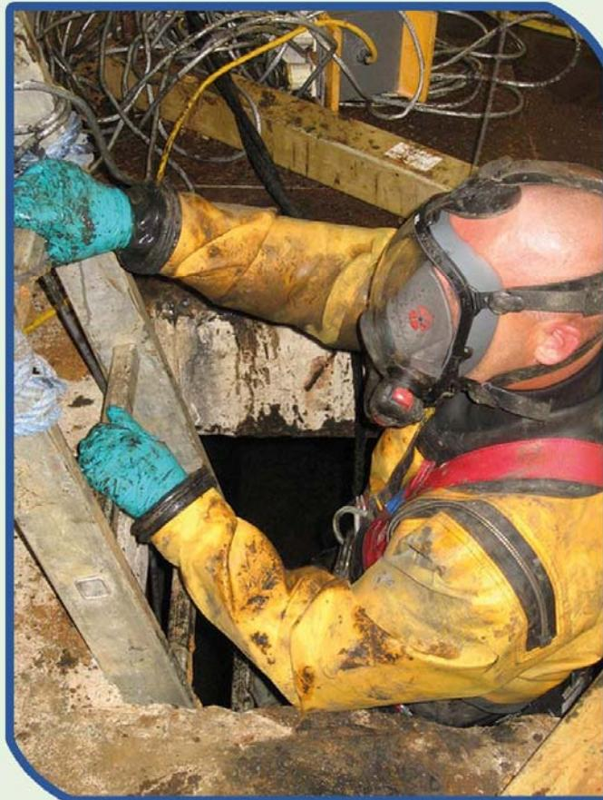
● قبل از ورود به داخل ظروف و مخازن باید ارتباط آن با ظروف مرتبط و نیز تمامی مسیرهای ورودی و خروجی قطع شود. لذا باید تمامی شیرهای ورودی و خروجی از طریق گذاشتن صفحات مسدود کننده(Blind Flange, Spade) مسدود شوند. ضمناً لیست شیرهای بسته شده و لیست صفحات مسدود کننده باید به پروانه ورود ضمیمه گردد.
